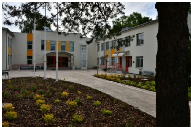
Jēkabpils novada sociālā dienesta Daudzfunkcionālais sociālo pakalpojumu centrs "ROSME", Jaunā iela 39i Jēkabpilī
