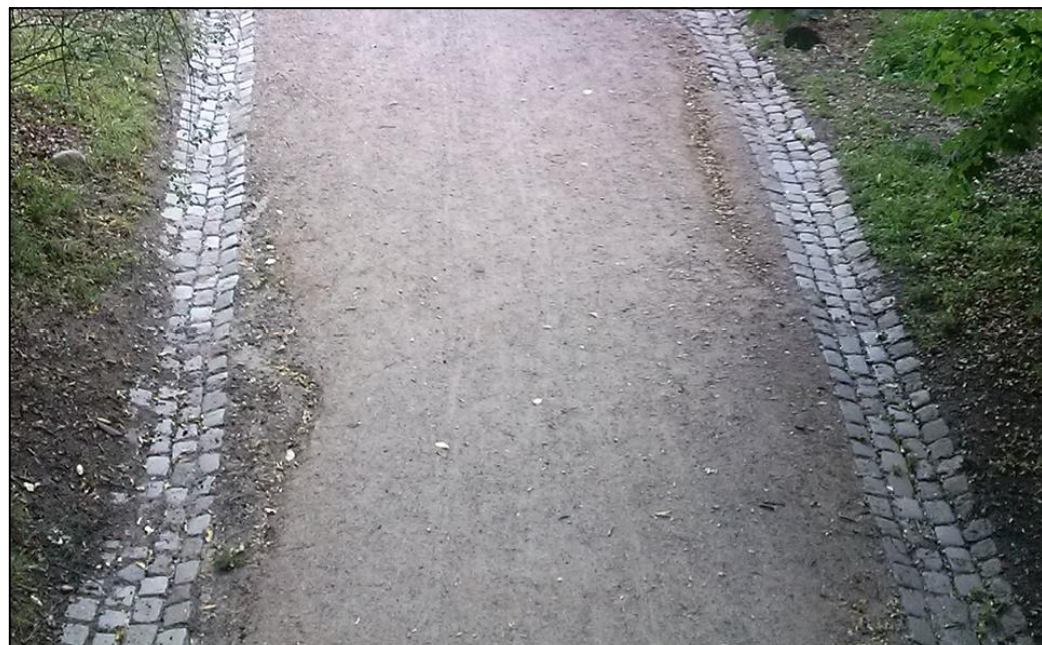
Grants takas pasargāšanai no izskalojumiem, piemērs
