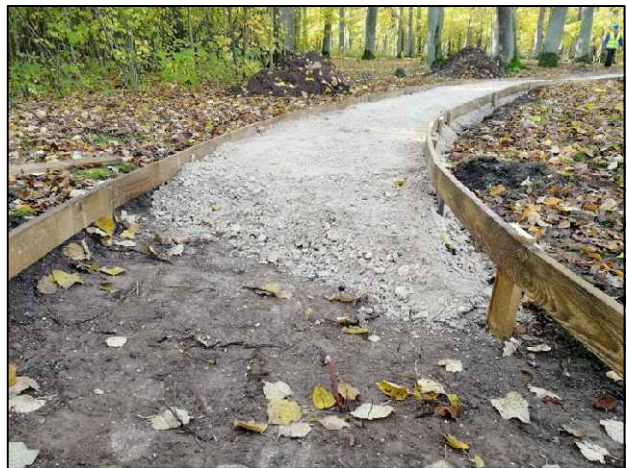
Grants celiņu izbūves process ar koka apmalēm
