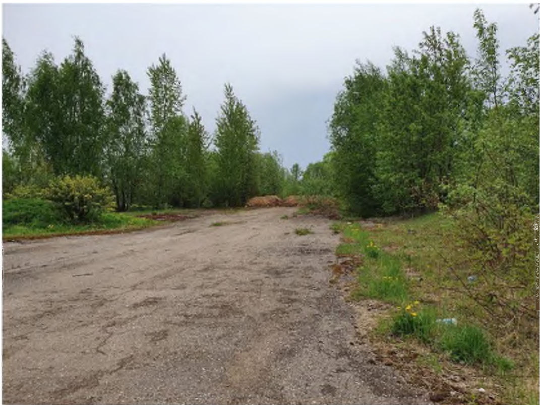
Bijušie ceļi un asfaltbetona laukumi.
