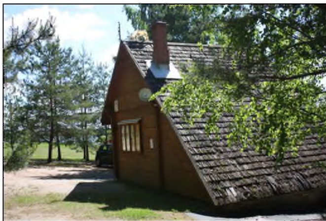
112 Peldvietas administrācijas ēka
