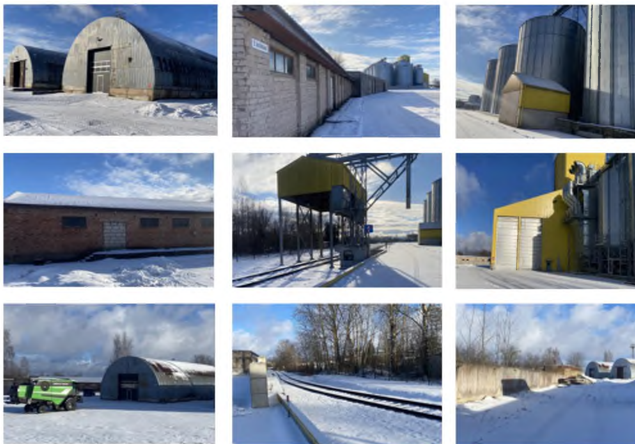
Fotofiksācijas. Būve Ārijas Elksnes ielā 6
