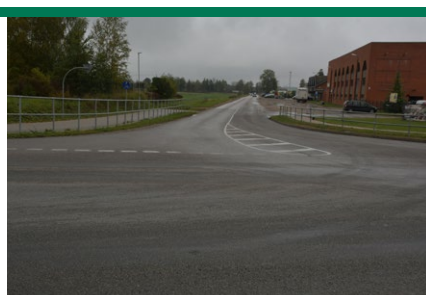
Pārbūvēs Ārijas Elksnes ielu Jēkabpilī
