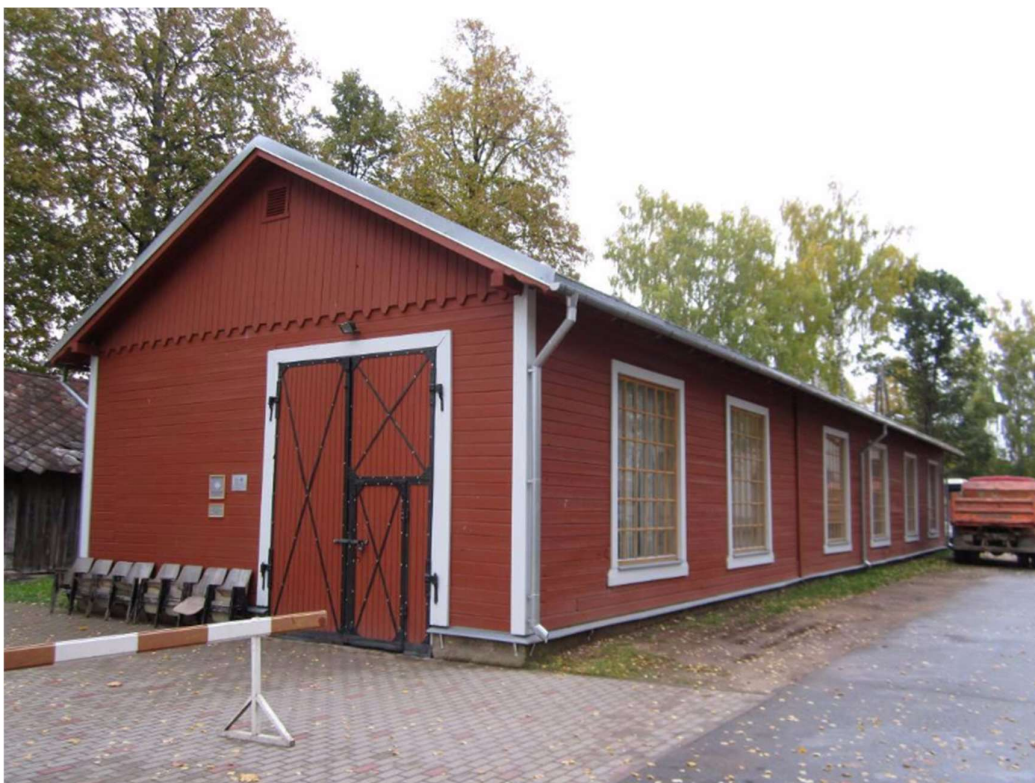
Attēls Nr. 5. Skats uz restaurēto Vagonu depo ēku no Z.
