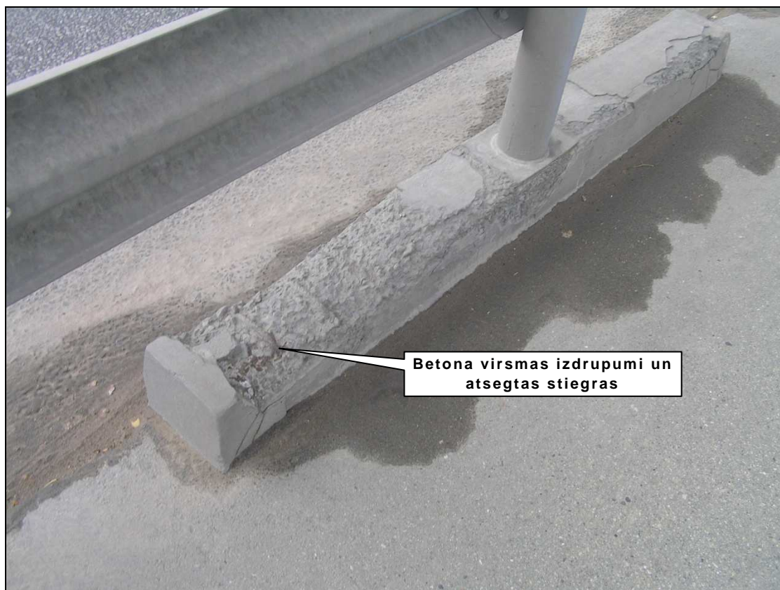
Dzelzsbetona apmale pie brauktuves malas
