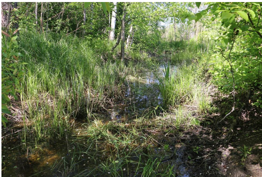
2.3.9. attēls. Aizaudzis un daļēji aizsērējis, tomēr ekstensīvi funkcionējošs senākas, 19.gs. beigās - 20.gs. pirmās puses meliorācijas sistēmas novadgrāvis Priekulānu ezera D krastā. ( X_{LKS-92TM} = 609664 un Y_{LKS-92TM} = 246513 ) (Foto: J. Soms)
