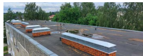
Ventilācijas izvadi pēc remonta mājā Mežrūpnieku ielā 8
