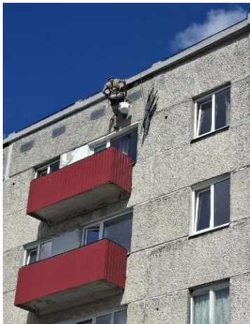
Vairākām mājām tiek veikti paneļu šuvju hermetizēšanas darbi
